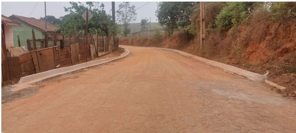
Ínicio do trecho a ser pavimentado.
